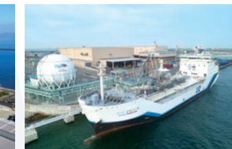
液化水素荷役実証ターミナルと 液化水素運搬船「すいそ ふろんていあ」
