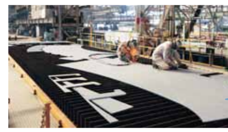
鋼板の切断・加工作業
