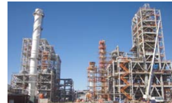
建設中の尿素プラント
