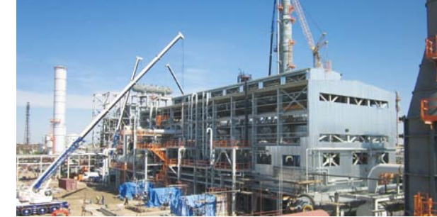
建設中のアンモニアプラント
