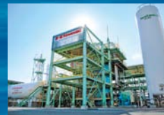
水素液化システム実証設備
