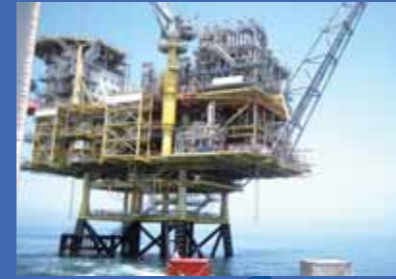
ガスコンプレッションモジュール
