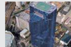
神戸クリスタルタワー
