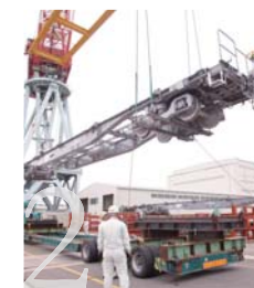
トレーラーへの積込
