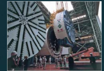
東京湾アクアライン用シールド掘進機の搬出作業
