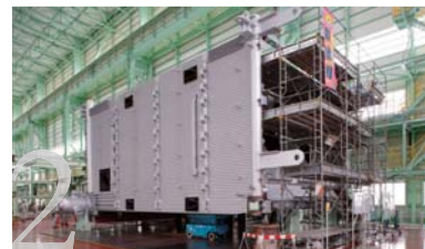
組立中の燃焼室
