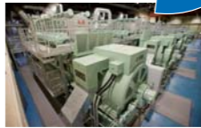
日本テクノ(株)袖ヶ浦グリーンパワー向け ガスエンジン発電設備
