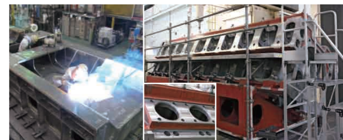
共通台板の溶接
