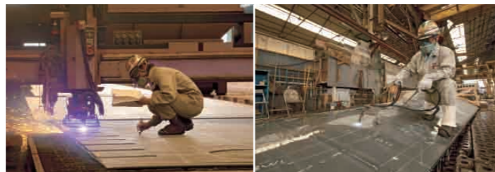
自動切断機による切断
