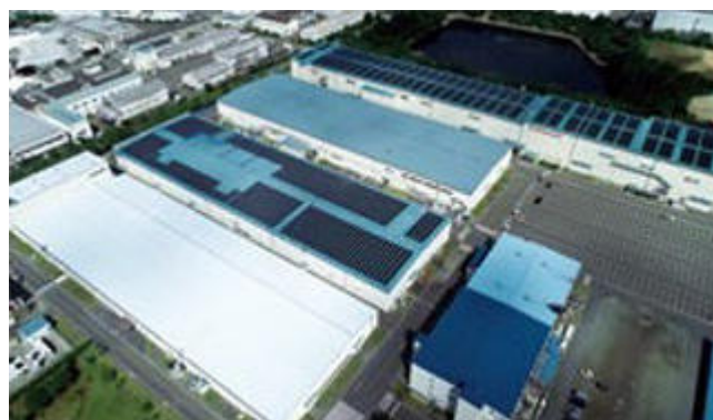
西神工場 1,444kW発電設備
