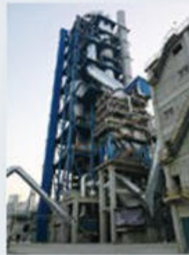
セメントプラント 排熱発電設備
