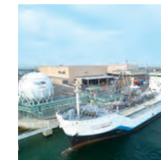
液化水素荷役実証ターミナルと 液化水素運搬船 「すいそ ふろんていあ」
