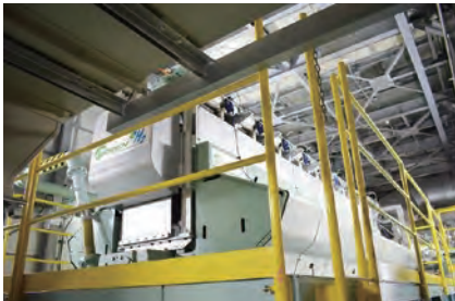
水素30%混焼ガスエンジン
