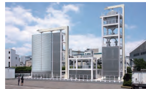
DACおよびPCCの新型実証設備
