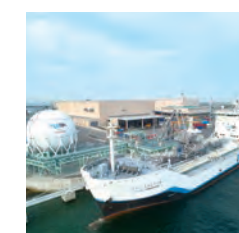
液化水素荷役実証ターミナルと 液化水素運搬船 「すいそ ふろんていあ」
