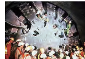
英仏海峡海底鉄道トンネル向け トンネル掘削機
