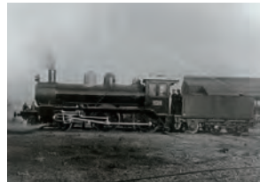
国産化第1号蒸気機関車
