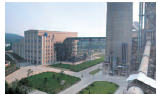
CKKシステム(セメント製造とごみ処理を一体化したシステム)
