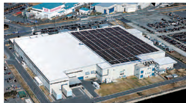
名古屋第一工場 750kW発電設備
