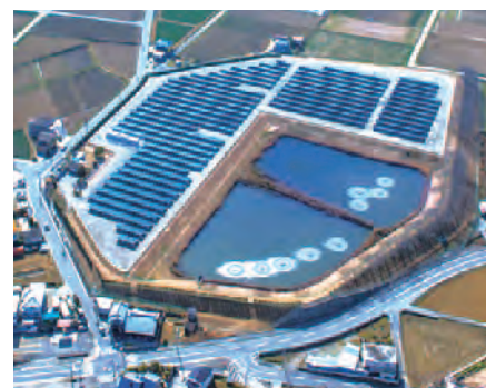
川重商事株式会社岩岡発電事業所 1,505kW発電設備
