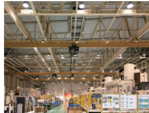
省エネ活動により工場棟の照明をLED化(西神工場)
