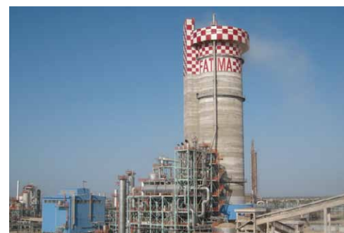
尿素製造設備
