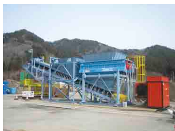
がれき破碎処理設備
