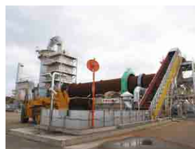
がれき焼却処理用設備
