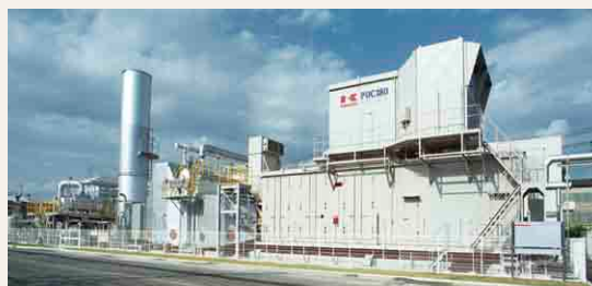
明石工場ガスタービン発電設備
