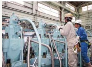
主要な機器の出荷前検査
