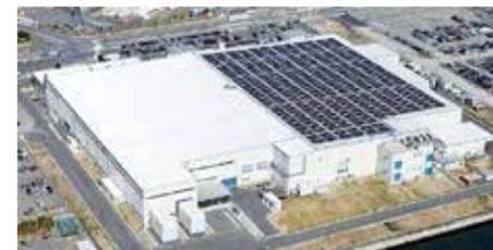
図10 名古屋第一工場 750kW発電設備
