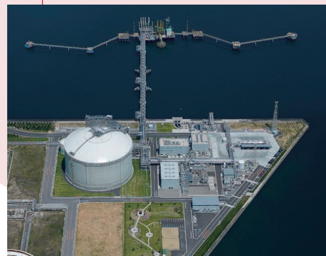
Sakaide LNG's LNG terminal (completed in 2010)
