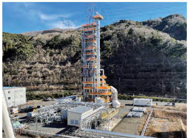
図5 移動層パイロットスケール試験設備 Fig. 5 Pilot-scale moving bed solid sorbent plant
