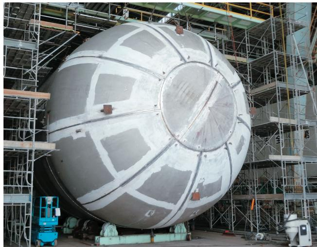
図5 試作中の陸上用LH<sub>2</sub>タンク
