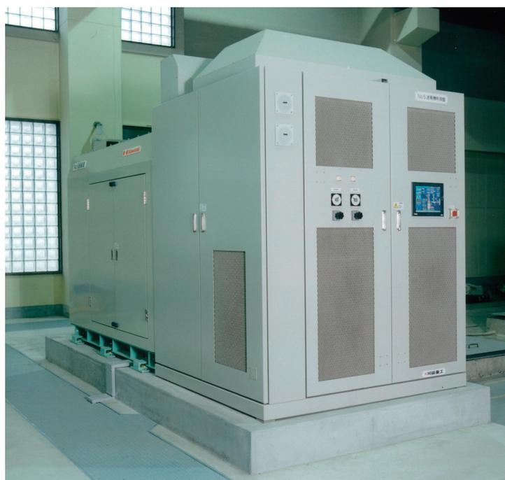
高効率かつメンテナンスフリーを実現する磁気軸受を採用した曝気用ブロワ
