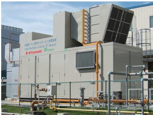
図5 低濃度メタン燃焼ガスタービン発電装置
