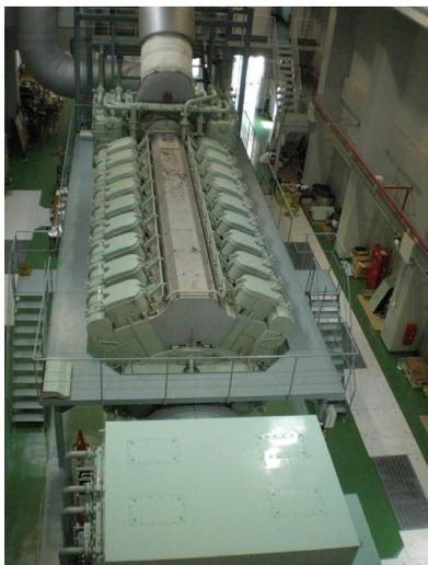
図6 沖縄電力向けディーゼル発電設備
