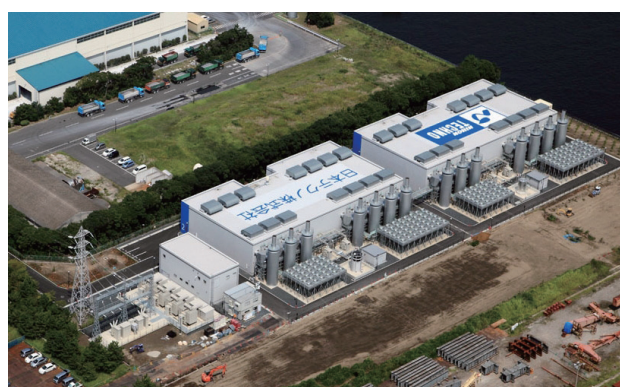
図8 日本テクノ(株)110MW級発電所 Fig.8 110 MW class power station delivered to Nihon Techno Co., Ltd.
