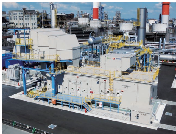
図8 L30AパッケージPUC300DとCHPプラント全景 Fig.8 Panoramic view of L30A package PUC300D and CHP plant
