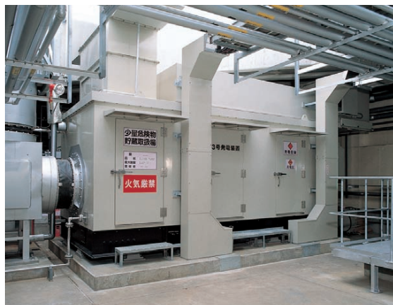
図6 デュアルフューエル仕様のガスタービン Fig.6 Gas turbine of dual-fuel specification
