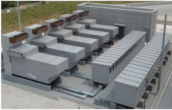
図1 データセンター向け3500kVA非常用発電装置
