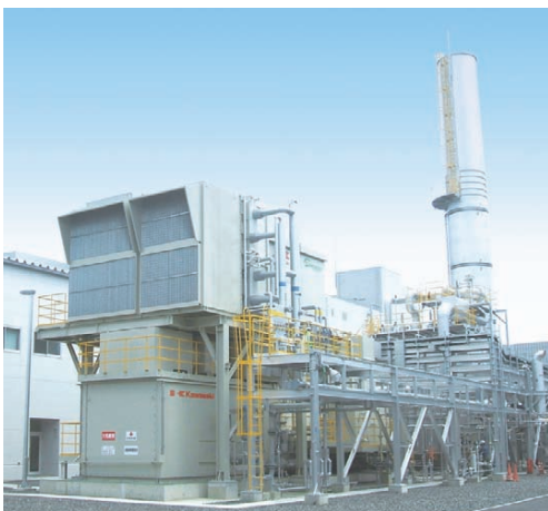
図4 PUC180Dガスタービンコージェネレーション Fig. 4 PUC180D gas turbine cogeneration system
