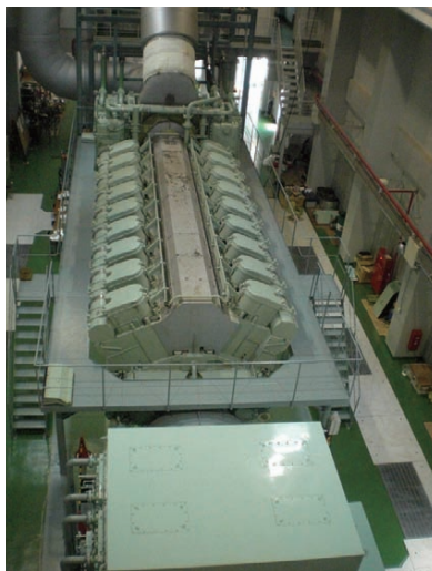
図6 沖縄電力向けディーゼル発電設備
