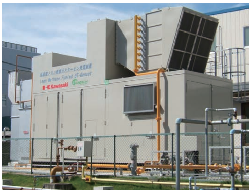
図5 低濃度メタン燃焼ガスタービン発電装置
