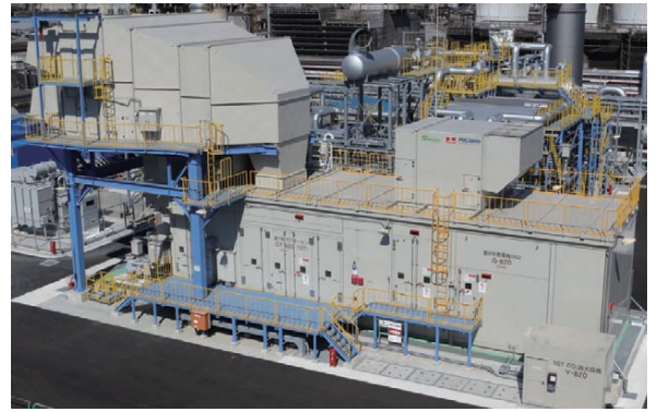
図3 30MW級PUC300コージェネレーション設備
