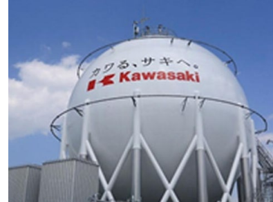
（液化水素貯蔵タンク）
