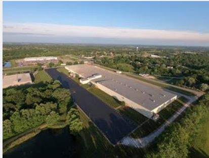
KMMブーンビル工場
