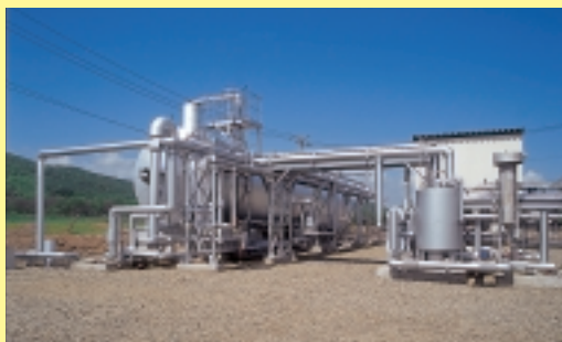
家畜排泄物のメタンによるバイオガス発電設備(北海道・湧別町)
