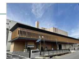
会津若松地方広域市町村圏整備組合向け新ごみ焼却施設の外観
