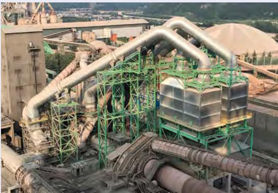
サンヨンセメント・東海工場向けセメント排熱発電設備
