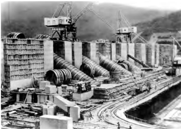
施工中の松花江発電所(満州国)水圧鉄管据付工事——1944年に製作
