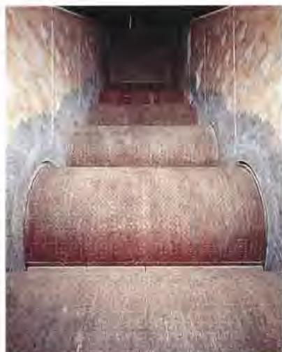
VKW式回転火格子方式ごみ焼却炉炉内
