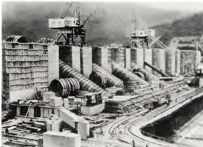
施工中の松花江発電所(満州国)水圧鉄管据付工事——1944年製作
