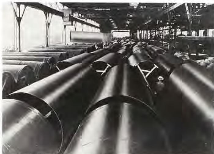
東京市向け水道用電気溶接鋼管——1933年納入
