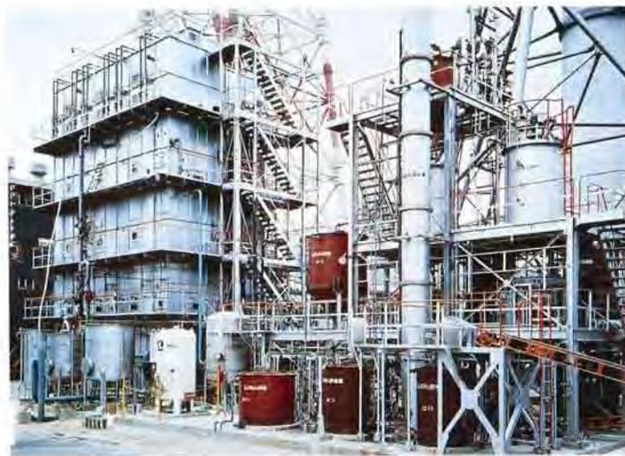
電源開発・竹原火力発電所に建設された湿式排煙脱硝プラント——1981年7月納入
