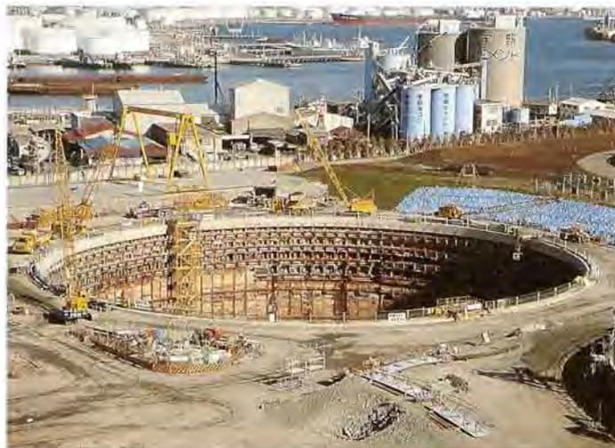
施工中の東京ガス・根岸工場地下式LNGタンク——1982年4月完成
