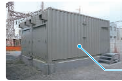
石津川変電所
