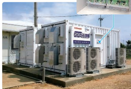
収納コンテナ外観 (手前コンテナに蓄電池収納)
