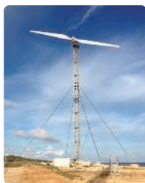
風力発電機 (沖縄電力殿)
