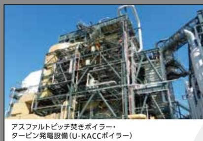
アスファルトピッチ焼きボイラー・タービン発電設備(U-KACCボイラー)
