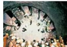
1991年 英吉利海峡海底铁路隧道挖掘机挖掘成功
