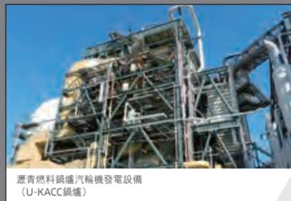
瀝青燃料鍋爐汽輪機發電設備 (U-KACC鍋爐)
