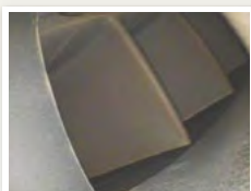
ボアスコープ実施例 (1段タービン翼)
