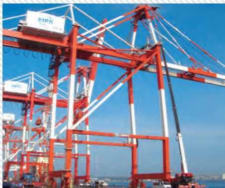
▶ 港湾荷役設備
