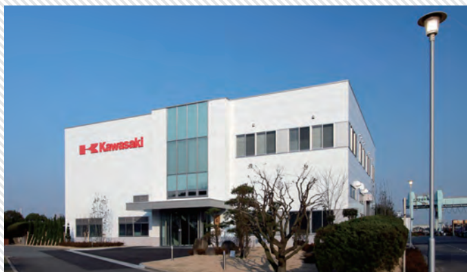
▶ 教育施設(建築工事一式)
