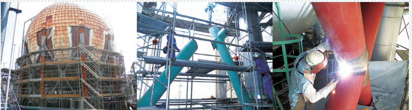
▶ タンク耐震補強工事
