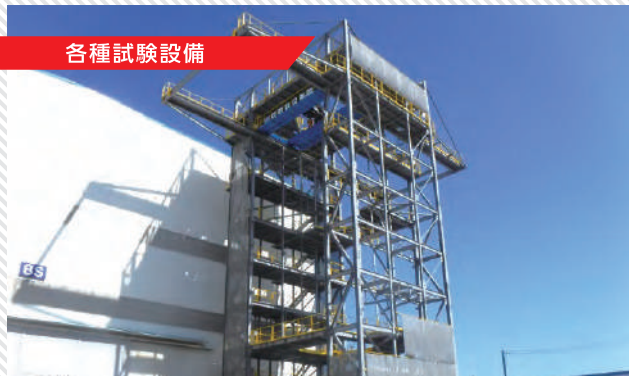
ロケットフェアリング試験タワー
