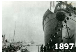
1897 伊豫丸 (川崎造船所第一番船) 進水
