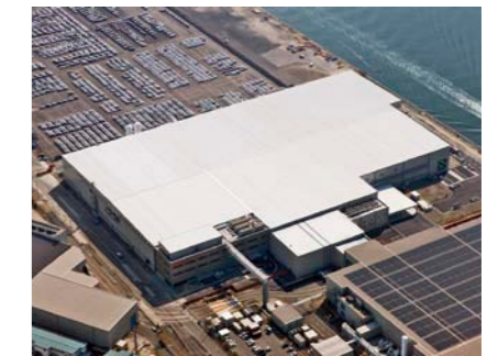
名古屋第一工場 東工場
