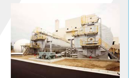
バイオガス化施設 発酵槽外観
