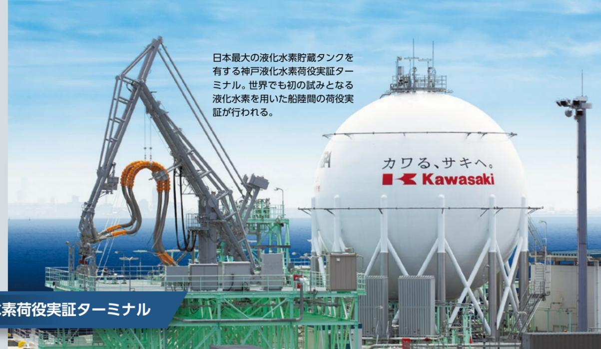
日本最大の液化水素貯蔵タンクを有する神戸液化水素荷役実証ターミナル。世界でも初の試みとなる液化水素を用いた船陸間の荷役実証が行われる。
