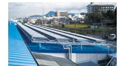
吸収式冷温水器に太陽熱を組み合わせ、工場や大型店舗の冷暖房を高効率に行うソーラークーリングシステム
