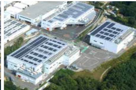
図14: 西神戸工場 927kW発電設備 (内422kWはFITによる販売)
