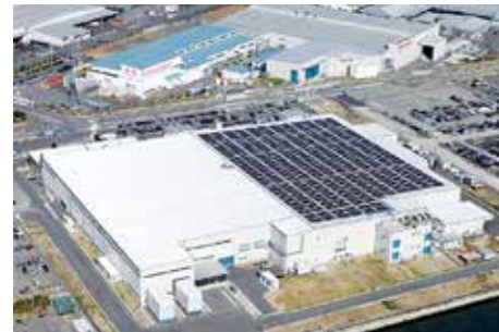
図13: 名古屋第一工場 750kW発電設備
