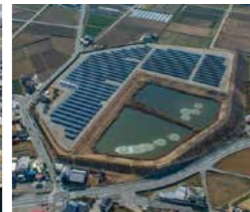
図10：川重商事株式会社岩岡発電事業所 1,505kW発電設備
