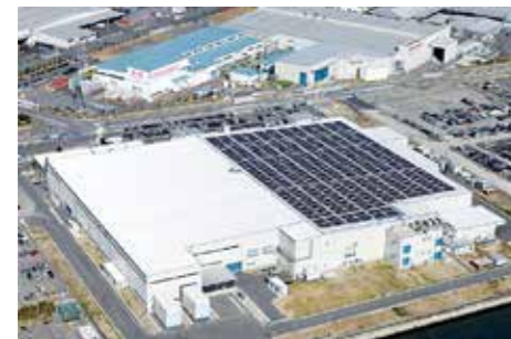
図9：名古屋第一工場 750kW発電設備
