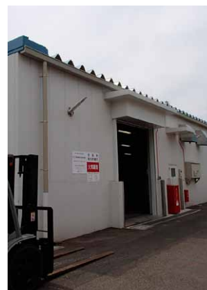
PCB保管倉庫
