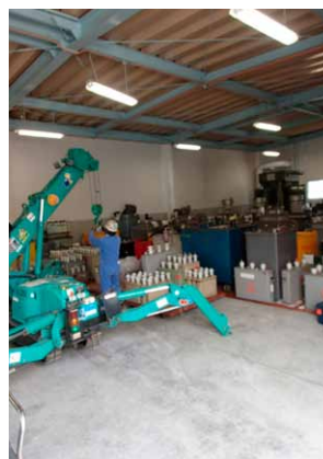
PCB排出作業状況
