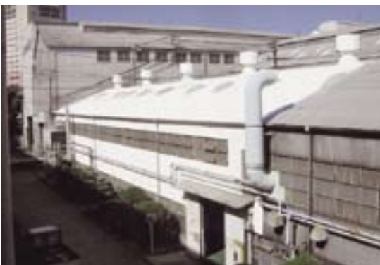
遮熱塗装された工場棟
