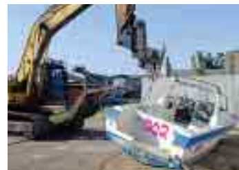
廃FRP船の粗解体
