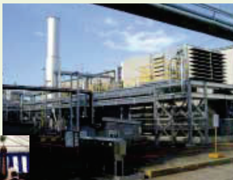
コージェネレーション設備
