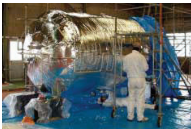
断熱材の施工
