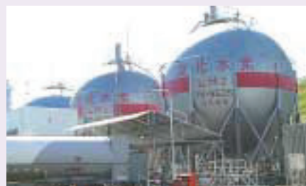
H-IIロケット「液化水素貯蔵供給所」
