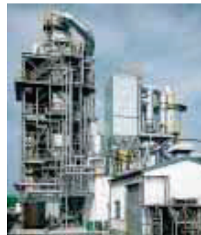
▲内部循環流動床炉
