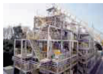
▲流動床ガス化溶融炉
