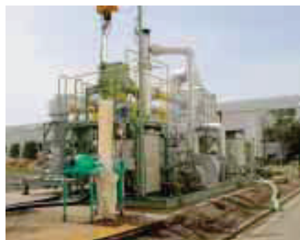
▲下水汚泥活性炭化設備
