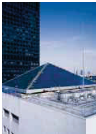
▲太陽光発電設備
