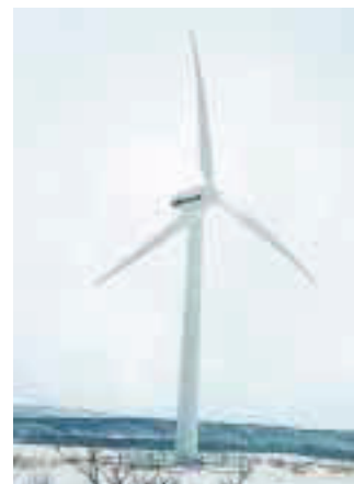
▲風力発電設備
