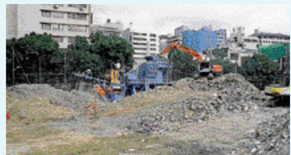
神戸市・磯上公園に設置されたジョークラッシャ
