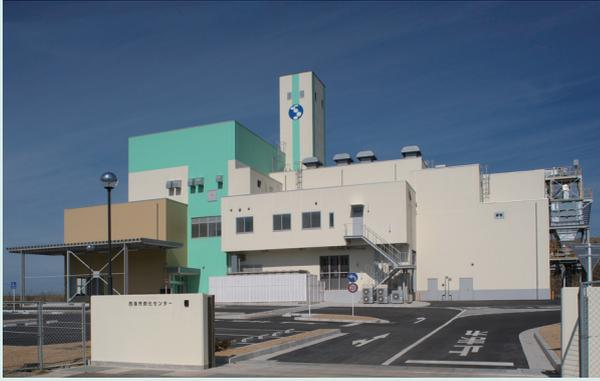
当社は2015年6月末、長崎県西海市に「一般廃棄物（ごみ）炭化処理施設」を納入した。本施設は同市内で発生する一般廃棄物・汚泥などを、低い環境負荷で炭化燃料に加工する施設である。製造する炭化燃料は、民間の施設で石炭混焼燃料として有効利用する。コンパクトな炭化炉、高性能な排ガス処理設備、脱塩・造粒処理により、処理規模が小さい場合でも高効率な処理設備を提供することができた。
